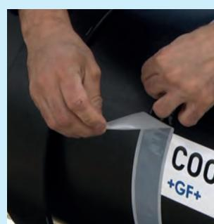
Dicht het verbindingsvlak tussen de fitting en buis af met afdichtingstape en krimp de krimpmof.
