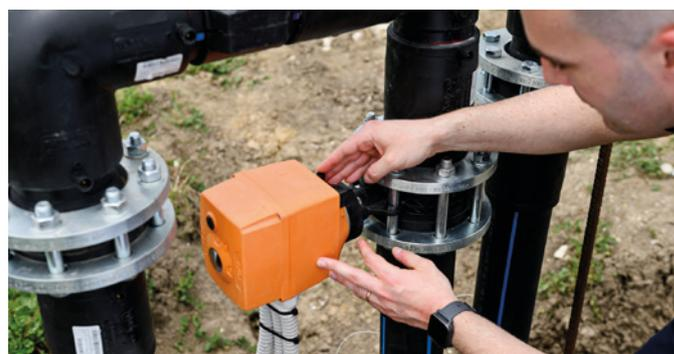
Grazie alle valvole azionate elettricamente, il sistema di irrigazione può essere controllato a livello centrale.
