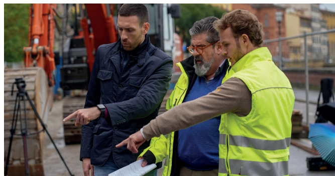
Rocco Sturchio, Direttore dei Lavori e Responsabile Manutenzioni di Publiacqua, supervisiona il lavoro presso il cantiere di Lungarno Serristori.
