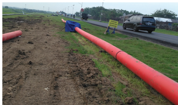
(HDPE Red layer PN 20 Hydrant pipeline.
