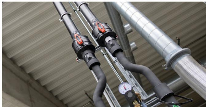
Les vannes à bille type 546 utilisées dans l'imprimerie.
