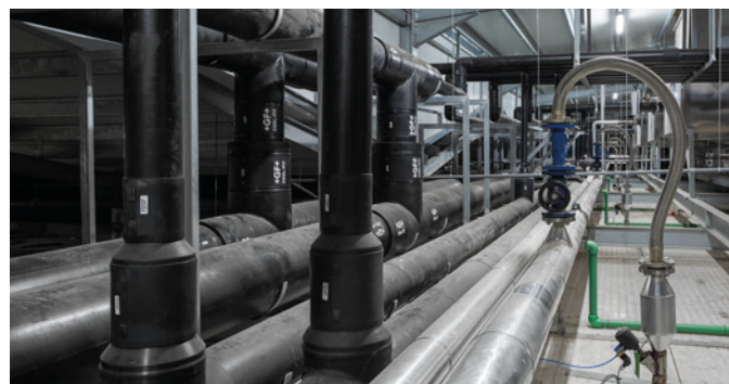
Près de 2 000 mètres de tubes COOL-FIT ont été installés chez Champinter.
