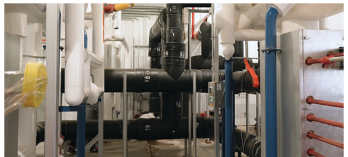
Sûrs, légers et rapide à installer, les tubes COOL-FIT 4.0 réduisent les contraintes structurelles sur les bâtiments et les structures de support, tout en diminuant le recours à des moyens de transport lourds et coûteux.
