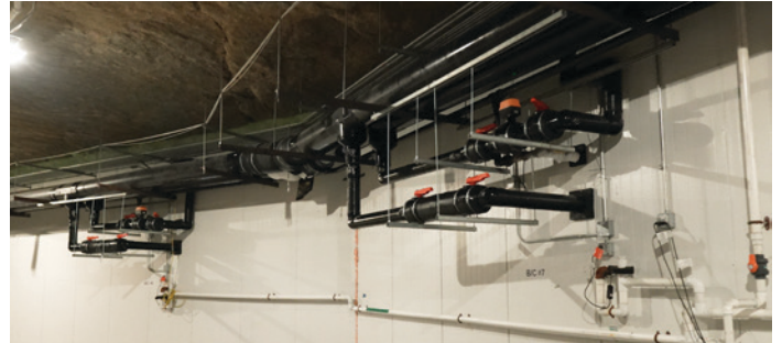
Le système COOL-FIT 4.0, associée aux vannes GF, offre des performances de refroidissement et une efficacité optimales pour l'installation frigorifique souterraine.
