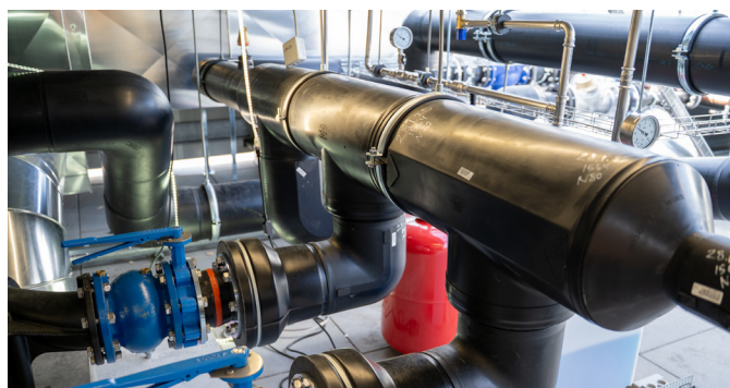
Mange komponenter blev leveret præfabrikerede, hvilket gav mulighed for hurtig og problemfri installation på stedet, hvilket reducerede byggetiden betydeligt.
