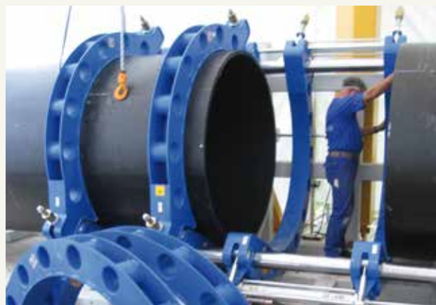
Svejsesforberedelse med GF 1600.
