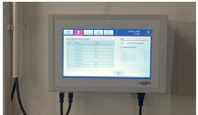
Über das zentrale Steuerungsgerät Hycleen Automation Master lässt sich die eingebaute Sanitärtechnik einfach bedienen. Das Panel ist mit Controllern verbunden, die die einzelnen Ventile und Sensoren präzise steuern.
