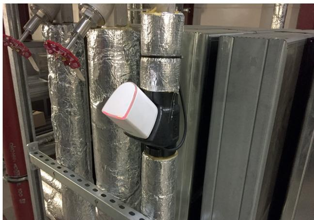
Das nachgerüstete Hycleen Automation System gewährleistet ein verlässliches Trinkwassermanagement mit gleichbleibenden Temperaturen über 55 °C und hydraulischem Abgleich.
