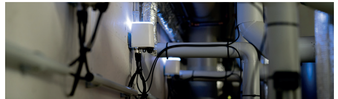
Die Ventile werden von den einzelnen Controllern gesteuert. Der Lichtring zeigt an, dass das Ventil aktiv ist. Die Öffnungs- und Schließzeit des Ventils beträgt lediglich 15 Sekunden.
