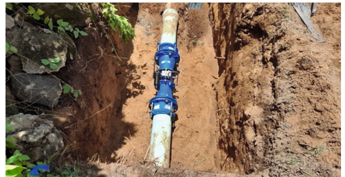
NeoFlow wurde für eine erhöhte Druckkontrolle in zwei Druckzonen installiert.
