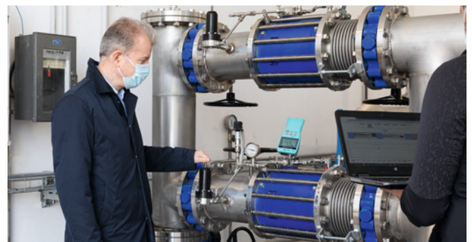
Installation eines NeoFlow Druckregelventils in der Dimension DN100.
