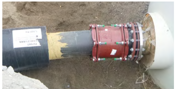
MULTI/JOINT® 3000 Plus lieferte die Verbindung, die die örtliche Verwaltung für ihre neuen HDPE-Anschlussrohren von Wasser- und Abwasserschächten zu den HDPE-Rohren suchte.
