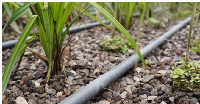
Die Beschickungseinrichtung besteht aus mehreren Röhren im Abstand von circa 40 cm, die zur Verteilung des Abwassers auf der Oberfläche der Pflanzenkläranlage gleichmäßig perforiert wurden.
