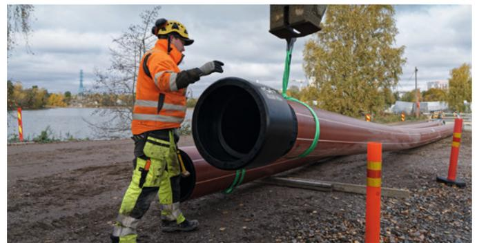
Einfache und schnelle Installation der ELGEF Plus-Elektroschweißmuffe.
