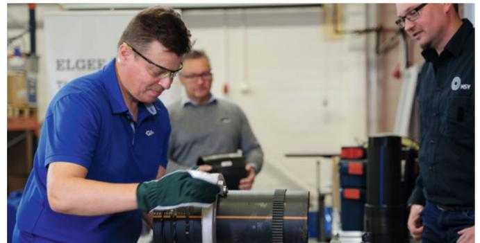
GF Piping Systems führt Vor-Ort-Schulungen zur korrekten Installation des ELGEF Plus-Systems durch.
