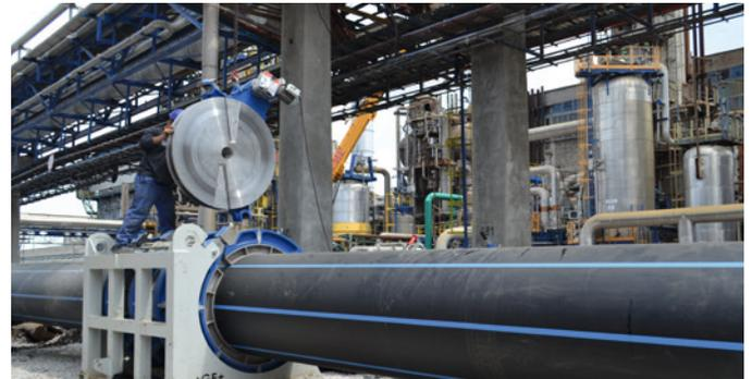
Zuverlässige Verbindungsqualität mit Stumpfschweissmaschinen von GF Piping Systems.
