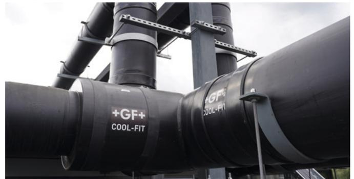
Das leichte, größtenteils vorgefertigte Rohrsystem ließ sich mühelos montieren und durch Elektroschweißen innerhalb weniger Minuten zuverlässig verbinden.
