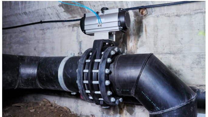
Erfolgreiche unterirdische Testinstallation der Absperrklappe 565 Big in DN400 im Aussenbereich der Schlossbadi.
