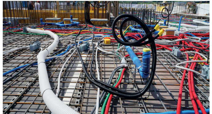
Die iFIT-Rohre (schwarz) sind für die Trinkwasserversorgung der Wohnungen eingelegt
