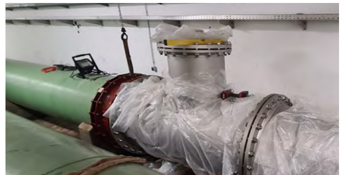
Wenn Neu auf Alt trifft, ist Präzision gefragt: Die hochbeständigen Edelstahlrohre mussten passgenau installiert und sicher mit den bestehenden Leitungen verbunden werden*.
