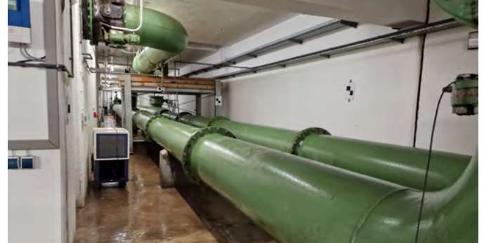
Wasser wird über zwei Leitungen zur Aufbereitungsanlage transportiert. Auf beiden Leitungen mussten die teilweise 50 Jahre alten Stahlrohre über eine Länge von 30 Metern ersetzt werden*.
