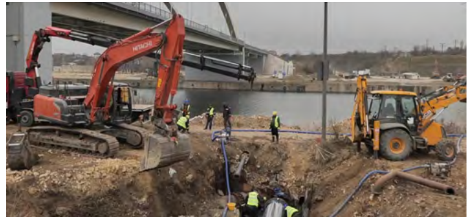
RAJA S.A. ersetzt einen zwei Kilometer langen Abschnitt einer DN1000-Wasserleitung, die die Stadt Năvodari und umliegende Gemeinden versorgt.
