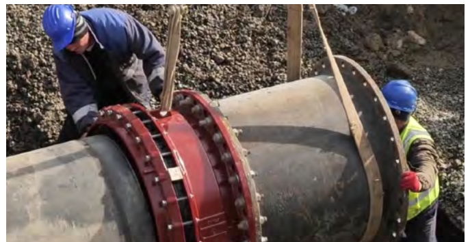
Schnelle und einfache Montage dank gut zugänglicher Schrauben – ganz ohne Spezialwerkzeug.
