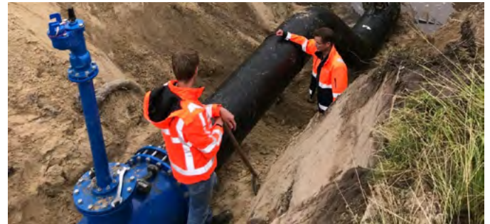
Verlegung eines AZ-Rohrs (500 mm) mit einem HDPE-Rohr.
