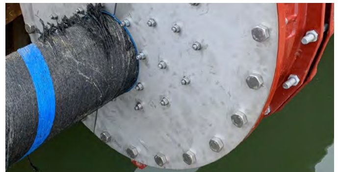
Die Abdeckplatte wurde auf den DN800-Flanschadapter installiert.
