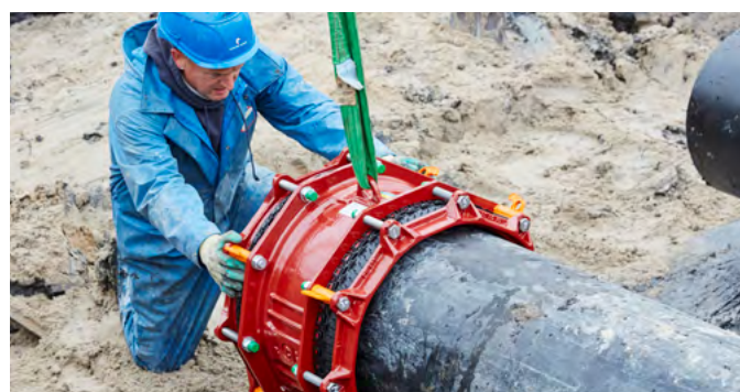
Durch die Vorinstallation von MULTI/JOINT® auf den Rohrenden (Überschiebe-Muffe) wurde erhebliche Zeit eingespart.
