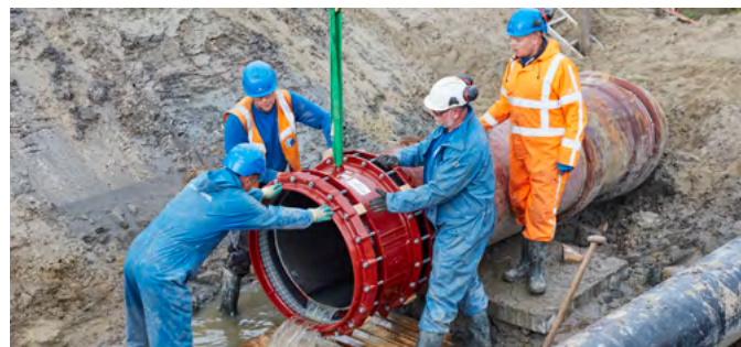
MULTI/JOINT® lässt sich dank seiner Vielseitigkeit mit einem Gusseisen-Rohr verbinden.
