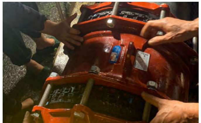
Die MULTI/JOINT®-Kupplung wurde erfolgreich an der Brücke installiert.
