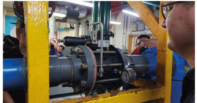
Das NeoFlow Druckregelventil kann aufgrund seines einfachen mechanischen Aufbaus und seines geringen Gewichts in weniger als einer Stunde vollständig gewartet werden.
