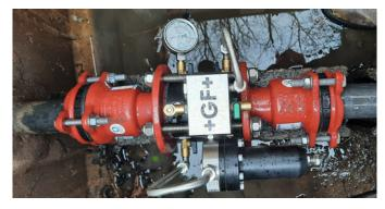
Dank seiner axial zur Durchflussrichtung gestalteten Bauform sorgt NeoFlow für einen stabilen Fluss bei 1% bis 100% Öffnung, selbst bei geringem Betriebsdifferenzdruck.
