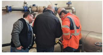
Das alte Druckregelventil aus Gusseisen wurde mit technischer Unterstützung von GF Piping Systems erfolgreich durch NeoFlow ersetzt.
