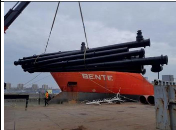
Um die Installation effizienter zu gestalten, wurden diverse Rohrabschnitte vorgefertigt und speziell auf die Bedürfnisse des Kunden abgestimmt.
