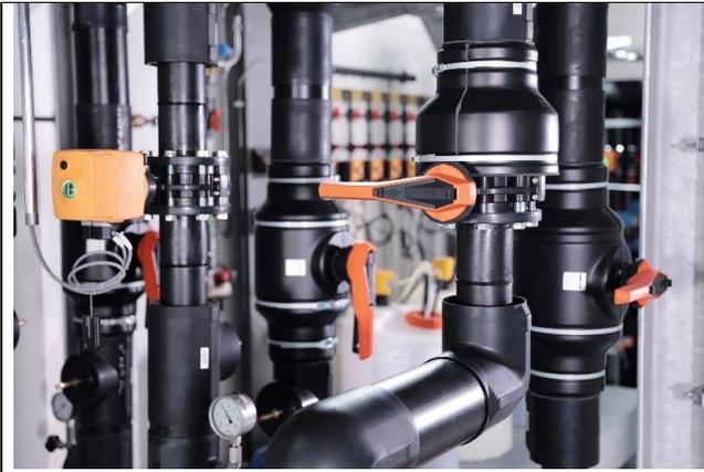
Installation eines vorisolierten COOL-FIT Rohrleitungssystem.
