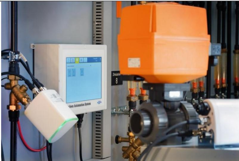
Das Hycleen Automation System optimiert Trinkwasserinstallationen mit digital verbundenen Ventilen und einem Master.
