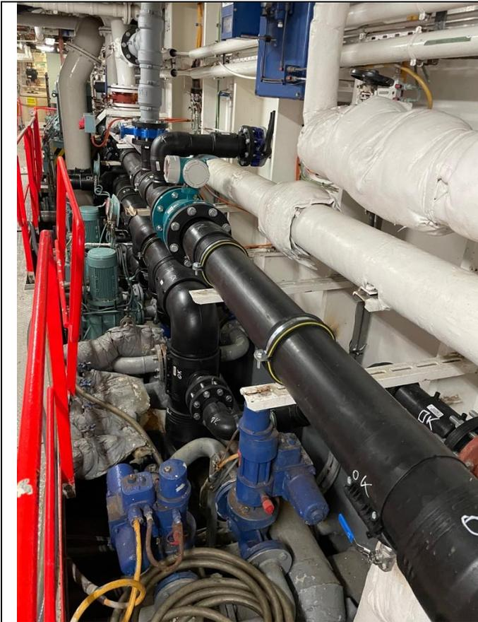
Aufgrund der Materialeigenschaften der ecoFIT und INSTAFLEX Rohrleitungssysteme, profitieren die Verteiler für heißes und kaltes Wasser von einem korrosions- und wartungsfreien Betrieb.
