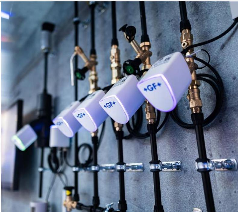
Das smarte Hycleen Automation System sichert dauerhaft die Qualität mit intelligent gesteuerten Ventilen in der Trinkwasser-Installation.
