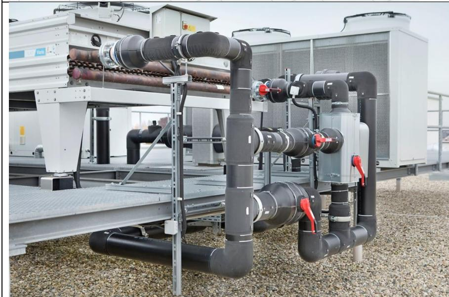
Die Leitwerk AG hat sich für ein vorisoliertes Kunststoffrohrleitungssystem entschieden, um die Energieeffizienz um bis zu 25% zu steigern.
