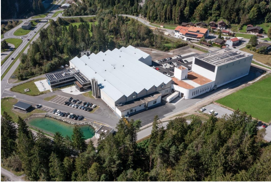
Das modernisierte Werk in Seewis
