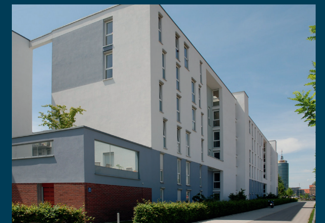
Complexe d'immeubles d'habitation dans le Max-Friedländer-Bogen à Munich avec BIOCAT KS 14000, conçu pour 110 unités d'habitation
