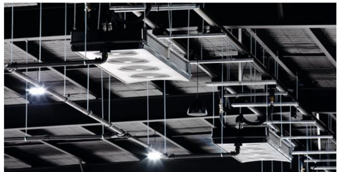
COOL-FIT 2.0 für die Klimatisierung (Kühlung und Heizung).
