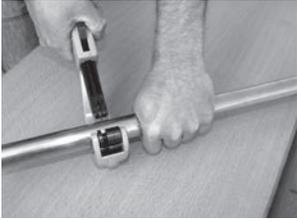
1 Chromstahl- oder Kupferrohr mit handelsüblichem Rohrabschneider oder feinzahniger Säge ablängen.
