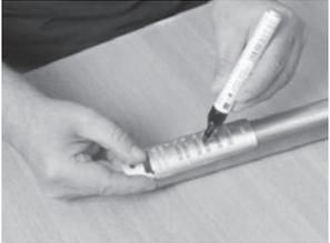
3 Mit dem Einsteektiefenwerkzeug ist die Einsteektiefe auf dem entsprechenden Rohr zu markieren.
