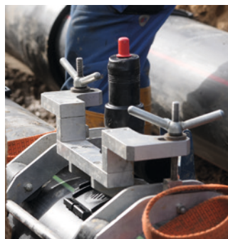
Für das Nachhaltigkeitsprojekt kommen u. a. Druckanbohrventile von GF Piping Systems zum Einsatz. Sie sind vor dem Schweißen um 360° drehbar.
