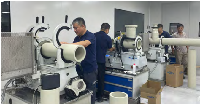
GF管路系统成功地结合了其四个主要预制件厂家的努力，提供1,000多个易于安装的PROGEF线轴。
