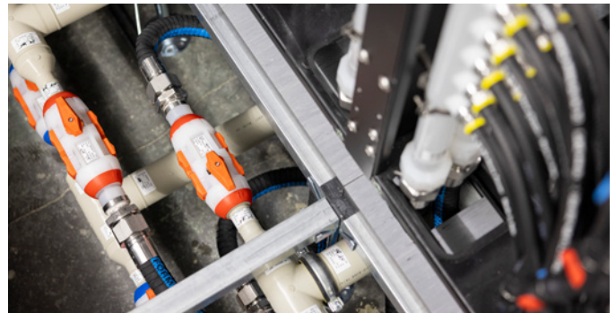
LiquidCore 专为白色空间的高效冷却而设计，其聚合物组件确保冷却液的极致纯净度。
