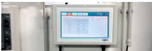
所有功能，如水力平衡和自动清洁，都由中央设备通过连接的阀门进行控制。始终可靠记录装置参数。
