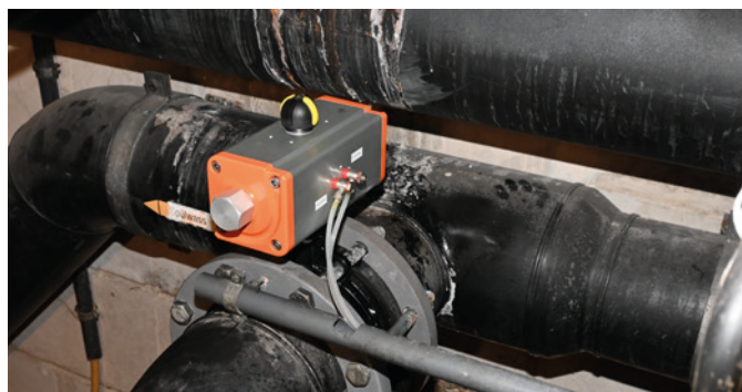
Nouvelle vanne papillon 565 dans le système de filtration
