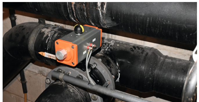
Neue Absperrklappe 565 in der Filteranlage
