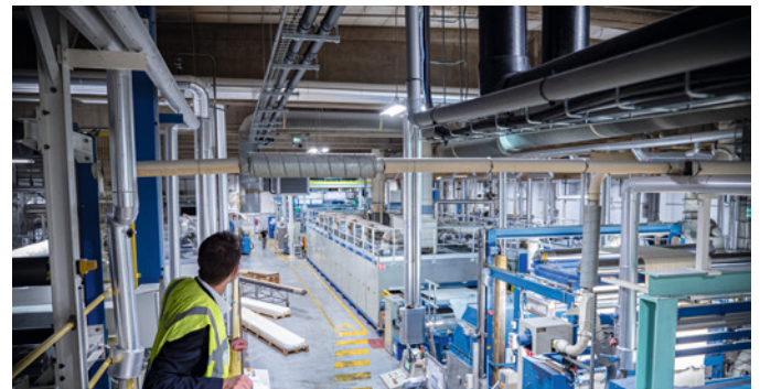
Die COOL-FIT Rohrleitungssysteme konnten ohne Unterbruch der Maskenproduktion installiert werden.
