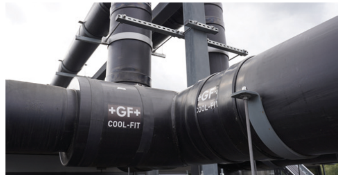
Le système de tuyauterie léger et en grande partie préfabriqué a été facilement assemblé de manière fiable par électrosoudage en seulement quelques minutes.
