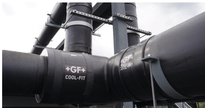
Das leichte, größtenteils vorgefertigte Rohrsystem ließ sich mühelos montieren und durch Elektroschweißen innerhalb weniger Minuten zuverlässig verbinden.
