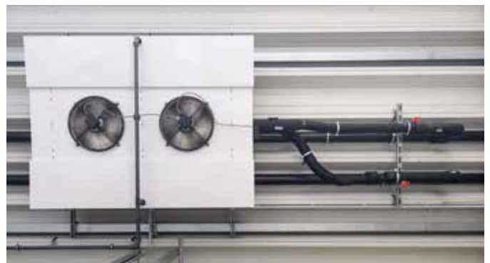
Der Anschluss an die Umluftkühler mit COOL-FIT 2.0
