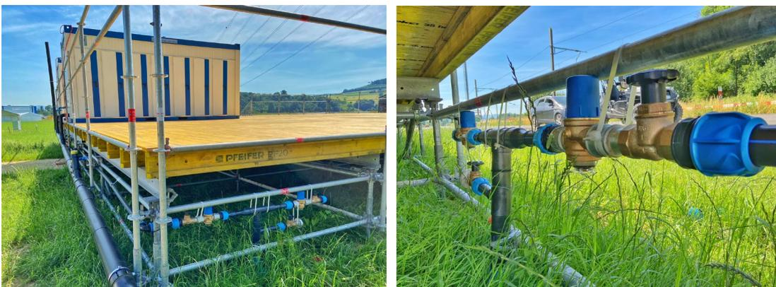
Die Installationen bei den WC-Anlagen mit Armaturen und Fittings von GF Piping Systems sind nicht unter den Podesten platziert, sondern seitlich, was die Montage erleichtert.
