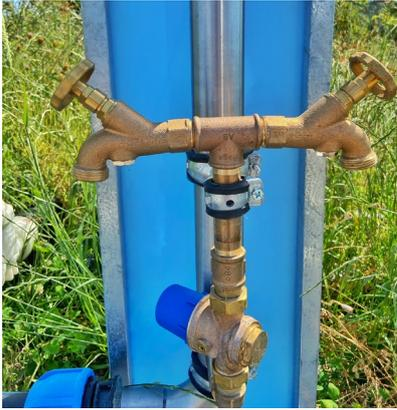
Überall im Gelände waren bereits im Juni Gartenventile von GF Piping Systems installiert, um eine dezentrale Trinkwasserversorgung sicherzustellen.
